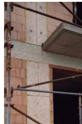
Eliminación de puentes térmicos.
